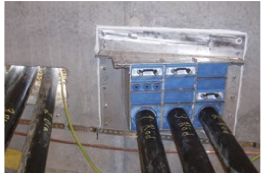
Roxtec GOHフレームは開閉可能で、既存のケーブルやパイプの向きに合わせて角度を付けて設置できます。
