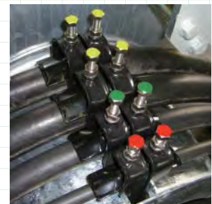
ケーブルクランプ取付状態 (CR-Wタイプ)
