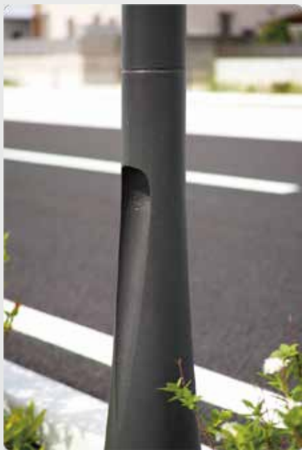
铸铁製フットライトと鋼管の スリップジョイント接合
