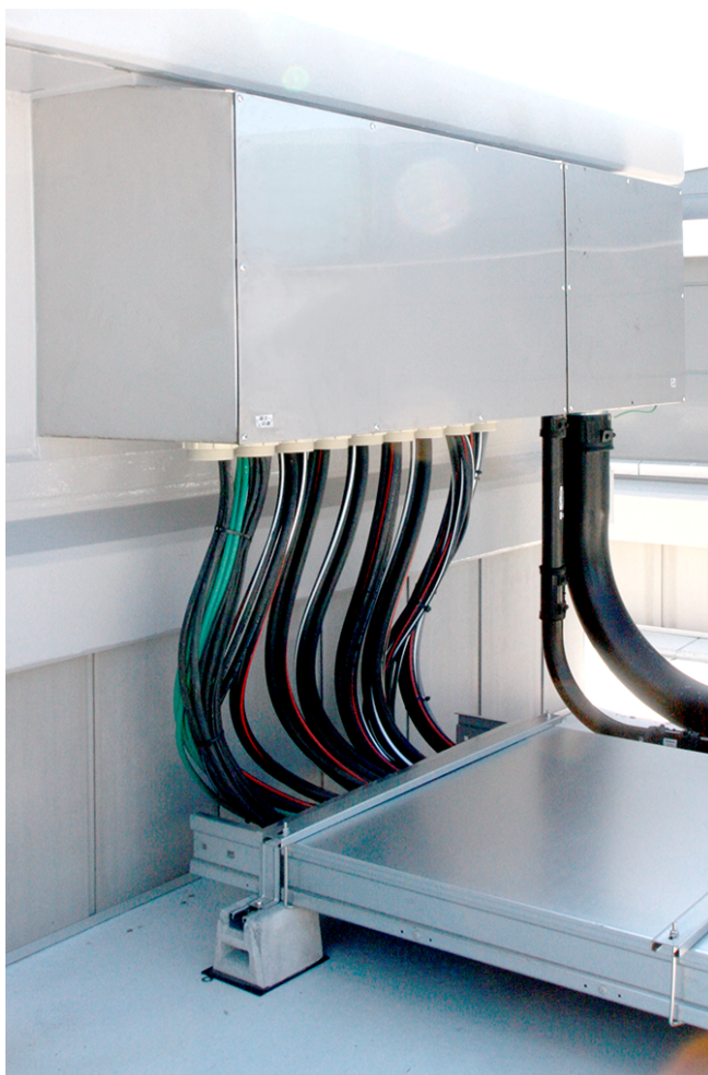
大型プルボックス（ステンレス製） / ケーブル用 孔加工
