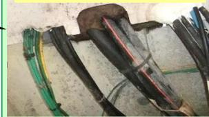
経年劣化により亀裂、隙間が出来、漏水するリスクがあります。
