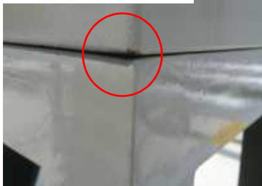
基台（チャンネルベース）と キャビネットの連結部分
