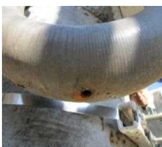
水抜き孔の加工
