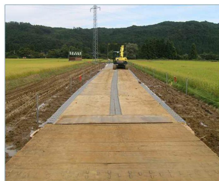
③上面に鉄板を敷設
