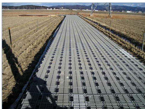
②スペーサーを敷設
