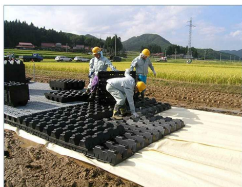
①プラロードを敷設
