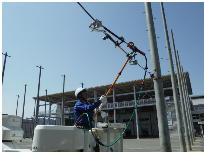
電線接続(圧縮)作業
