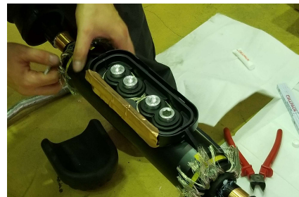
※スクリー方式採用6kV直線接続材CKM（JCAA K1301準拠試験合格品）
