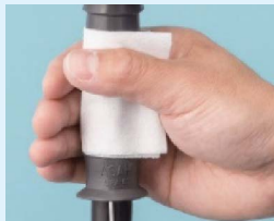
折り戻し部の清掃作業
