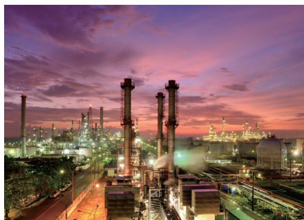
プラント設備
