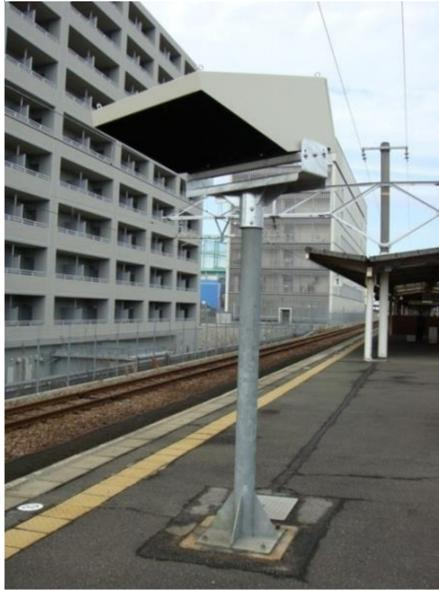
本装置は、列車の駅プラットフォームに設置され、適所に配置した監視カメラにて受像した映像をモニターにより写し出して、乗降客の安全確認を行うためのモニタ監視装置です。
