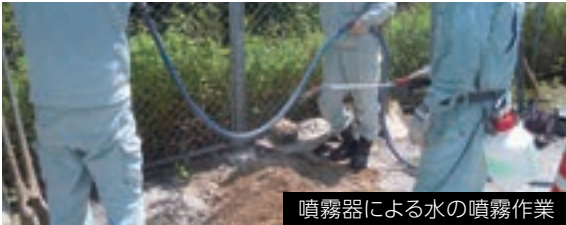
噴霧器による水の噴霧作業
