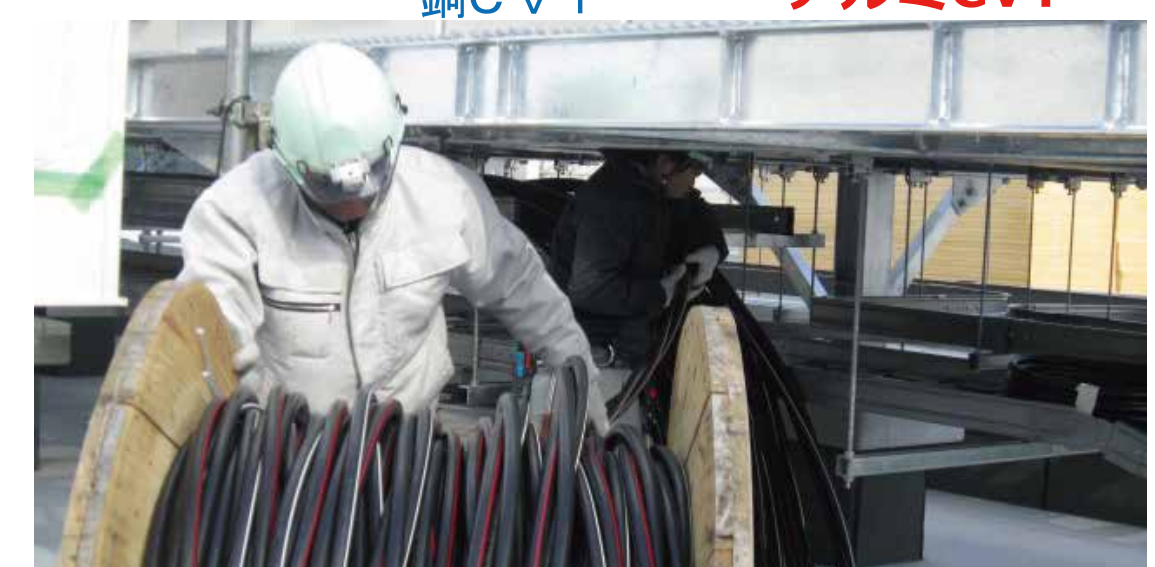
*某社工場食堂新築工事での アルミケーブル布設状況
