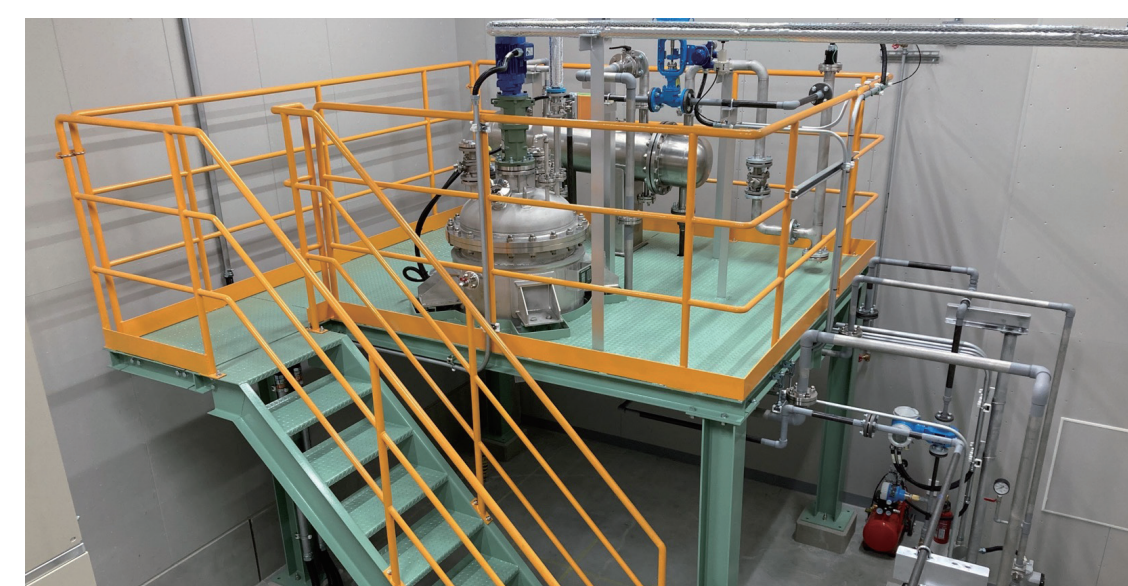
実際の完成状況
