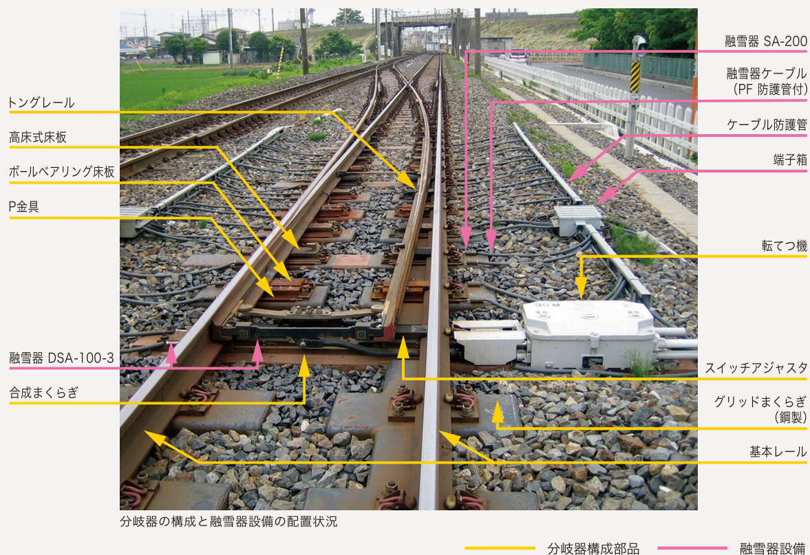
分岐器構成部品の解説
