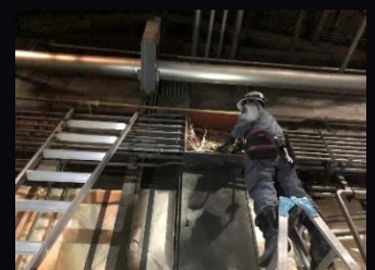
●回路切替工事
