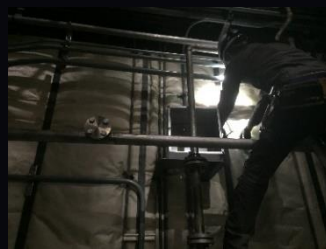
●電気設備据付工事
