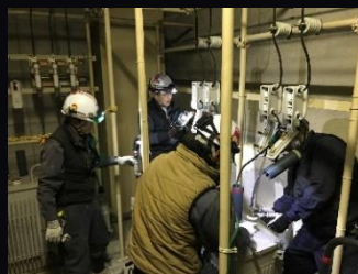
●キュービクル工事
