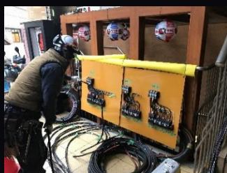
●仮設分電盤設置工事
