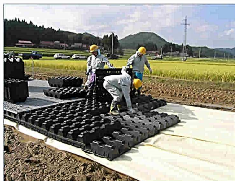
①プラロードを敷設
