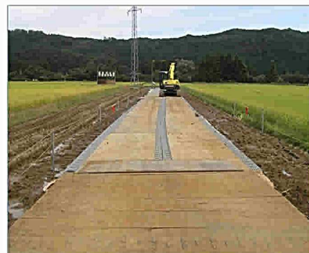
③上面に鉄板を敷設
