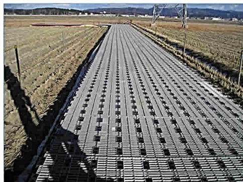
②スペーサーを敷設
