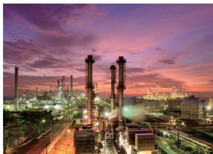
プラント設備
