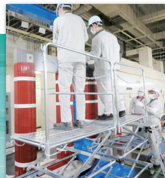
▲現地組み立てのようす
