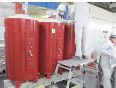
▲挿入したコイル間のクリアランスなど、細部をチェック。
