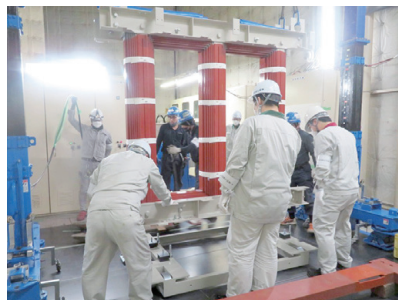
▲車輪つきの架台に防振ゴムを介して固定。
