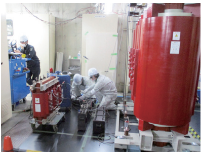
▲電氣的試験。試験用に持ち込んだ変圧器も、もちろん自社製品です。
