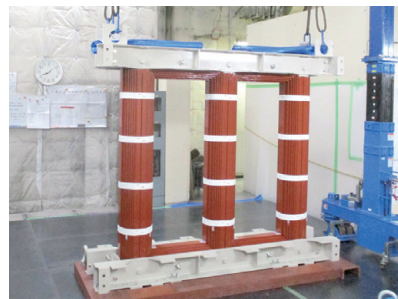
▲現地で組み上げた積み鉄心(完成)。重量約3.5トン。
