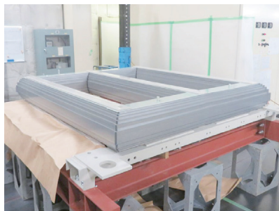
▲薄い銅板を現地で積み上げた鉄心。
