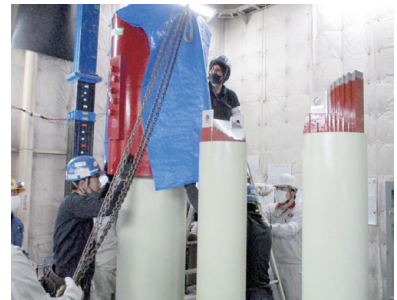
▲揚重屋さんによるコイルの挿入。グレーに見えるのはリショライト積層管の絶縁筒。
