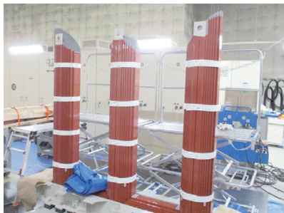
▲コイルを挿入するため一旦、上部ヨークと呼ばれる部分の鉄心を取り外した状態。
