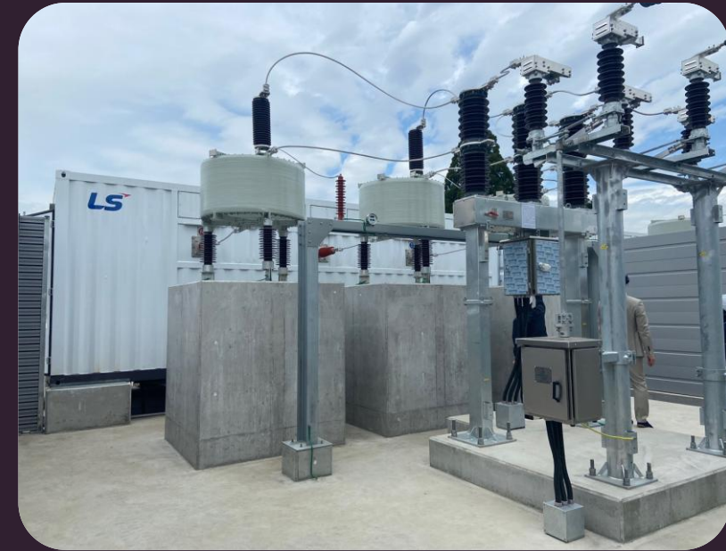
日本 | 28MVar 無効電力補償装置 (SVG) 電圧調整 | 2021年納品 | Solution Provider
