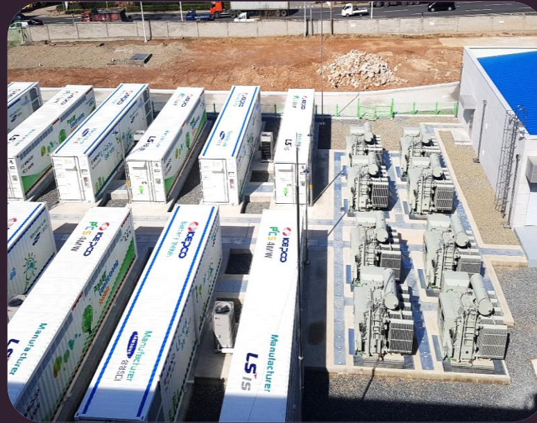
韓国 | 64MW/24MWh ESS 周波数調整 | 2014年建設 | System Integrator
