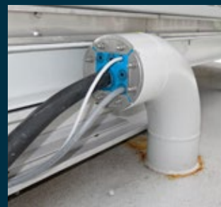
8. 屋上ケーブル貫通部
