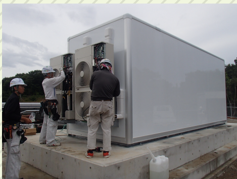
空調機点検・更新
