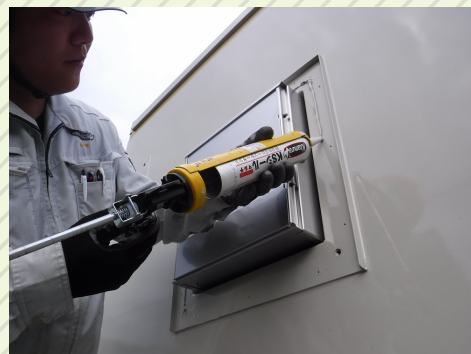
シーリング作業
