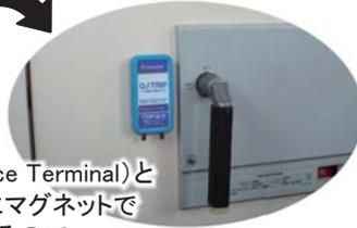
CTT(Current Trance Terminal)と同じ受電盤の表面にマグネットで取付けることが出来るので、配線が容易で事故率も低減!
