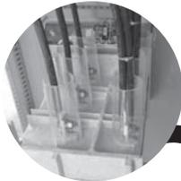
受電盤背面の遮断器(CB)へ試験器のトリップコードを直接接続する必要はありません
