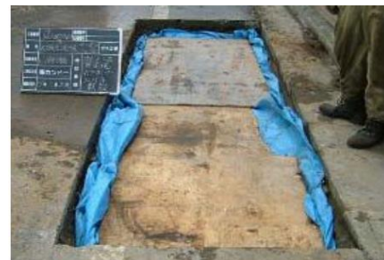
■ecoボールの上にシート、ベニア板（掘削機による損傷防止用）を配置
