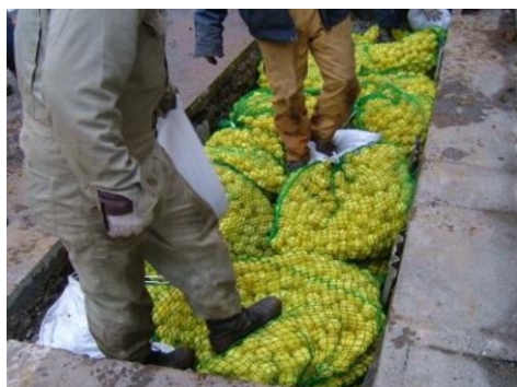
■ecoボール敷設
