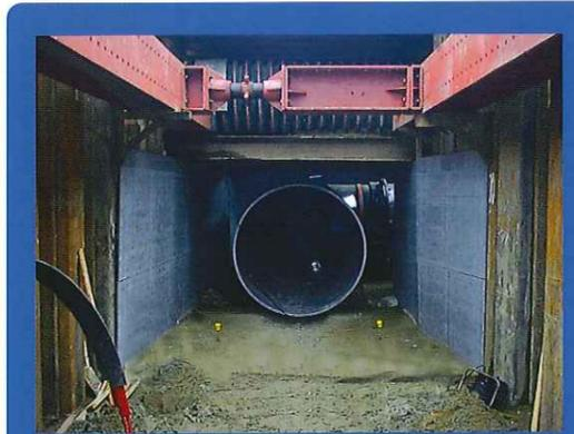
パイプライン工事で管の抜け出し・浮上り防止用スラストブロック部へ適用
