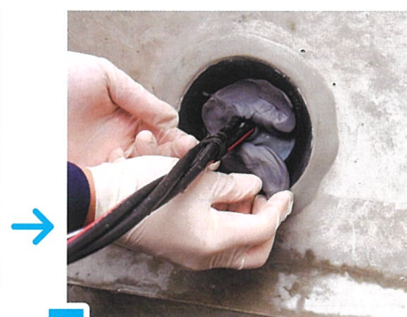
5 ネオシール施工中
