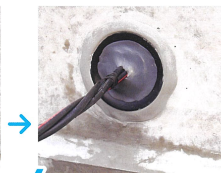
6 止水処理完了
