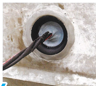
4 ミズストッパー施工完了
