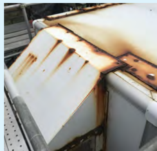
錆補修(部品交換)
