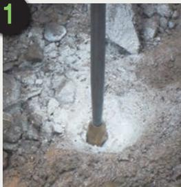
トップビットとスラストパイプを接続し、ハンド削岩機で削孔を開始します。
