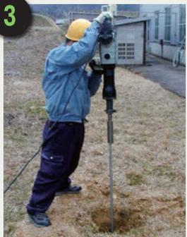
スラストパイプ上端に打ち込み工具をセットし、打ち込みを開始します。
