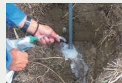
スラストパイプの上部が少し見える程度で打ち込みを終えてください。1本目のスラストパイプ打ち込みは終了です。
