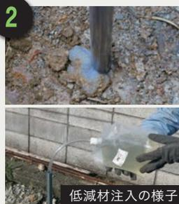
スラストパイプを地面に自立させた後、上端より低減材を注入し、スラストパイプの側面から低減材が出てくることを確認します。
