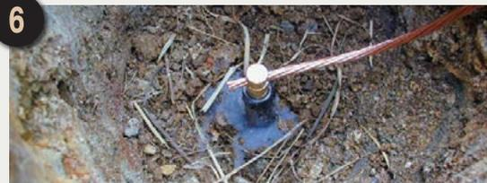
●抵抗値が規定値に達したところで規定深度に接地線をピン端子で接続します。（スラストパイプが途中で打ち込み不可能となった場合やパイプ端部が変形している場合は、グラインダー等でスラストパイプを切断し、ピン端子で接続してください。）
