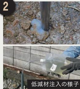
スラストパイプを地面に自立させた後、上端より低減材を注入し、スラストパイプの側面から低減材が出てくることを確認します。
