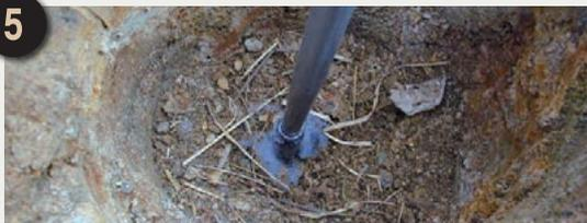
●1本目を打ち終わった段階で接地抵抗値が規定値に達しない場合は、1本目のスラストパイプに2本目を継ぎ足し、1本目と同様、低減材を注入してから打ち込みます。
