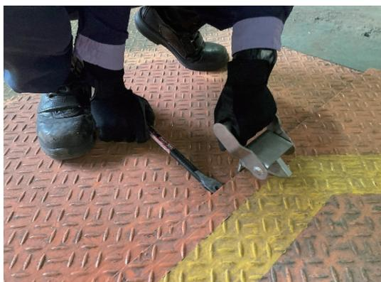
①バール等を使用しピット蓋を持ち上げ、UC-1を挿入する。
