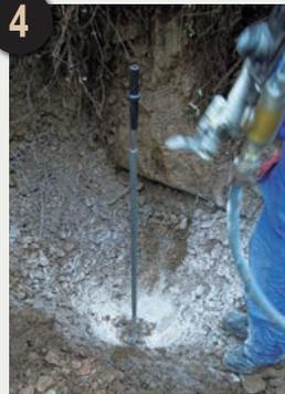
•1本目の削孔終了後、1本目のスラストパイプに2本目のスラストパイプを接続します。接続後、1本目同様に削孔を行います。
