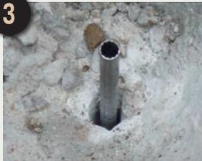
•スラストパイプの上部が少し見える程度で削孔を終えます。
