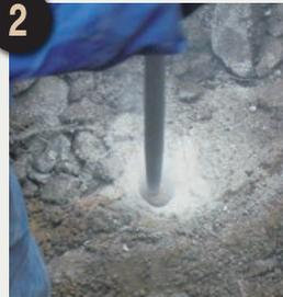
•はじめは削孔位置がずれやすいため、ゆっくりと削孔し、10～30cm程度削孔してください。
