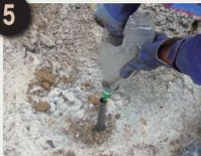
•削孔後、ピージェルをスラストパイプに注入します。削孔深度が深い場合はエアブローを利用し、奥までしっかりと充填してください。
